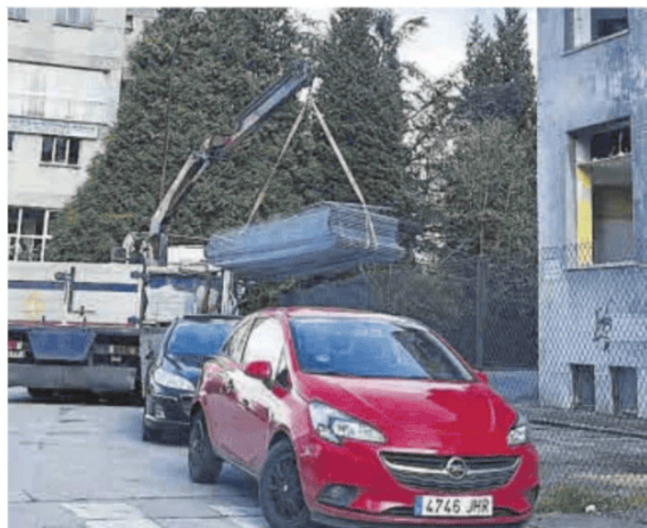
Los trabajos de descarga de material, ayer por la tarde, en el antiguo HUCA.
