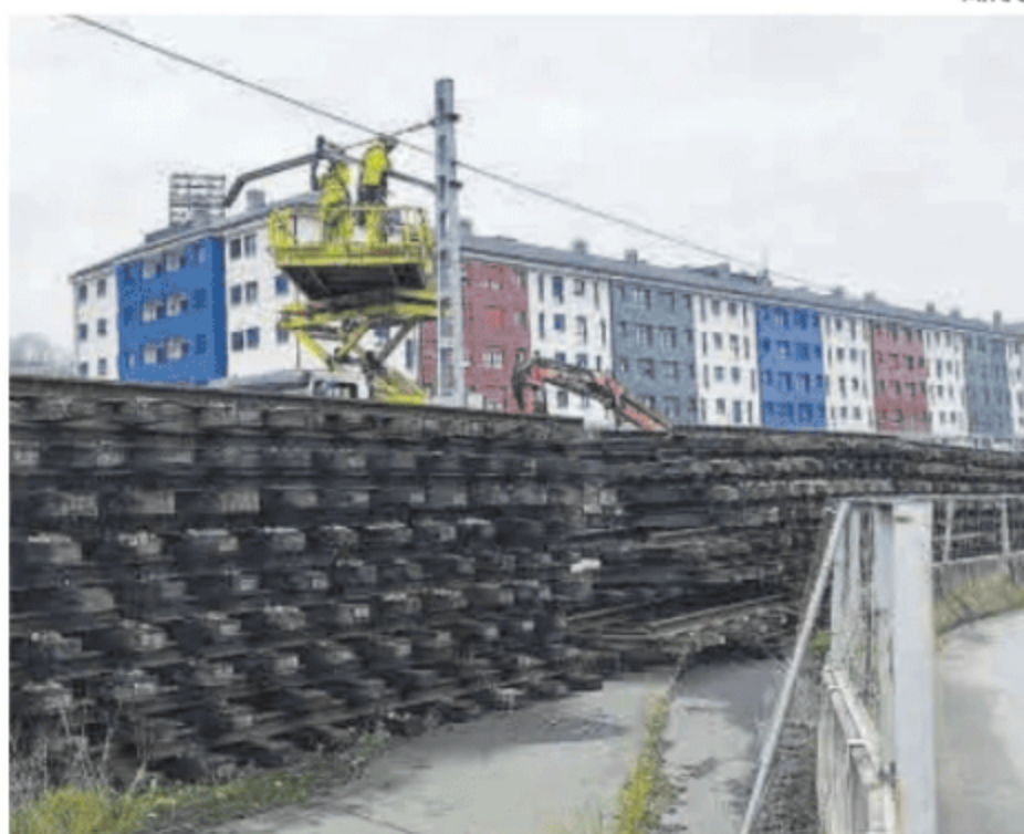
Retirada de la catenaria en La Felguera.
